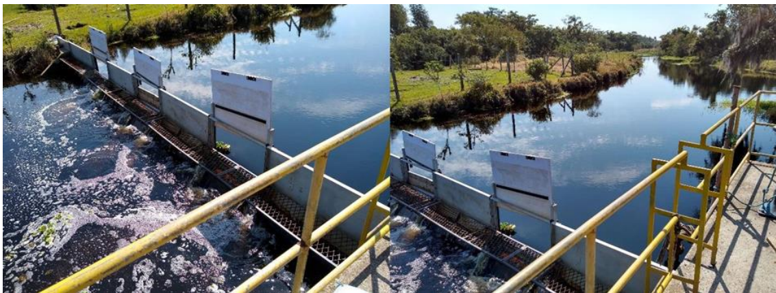
Figura 3 - Local da captação do manancial superficial
