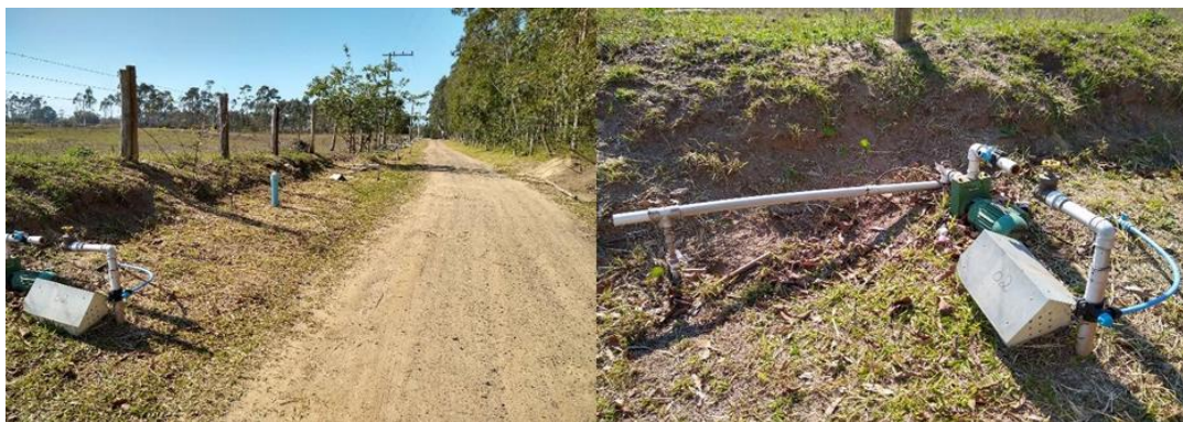
Figura 6 - Estruturas de captação subterrânea de poços desativados
