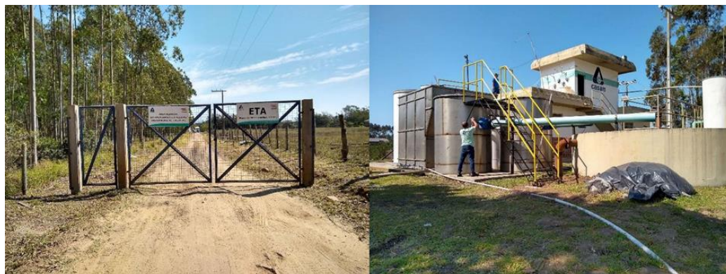
Figura 8 - ETA do SAA Passo de Torres
